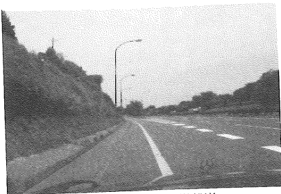
事故現場となった常磐道
