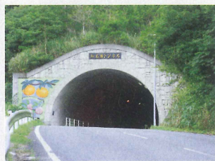
隆陸さんが工事に携わった奄美大島の知名瀬トンネル。半年後の完成を見届けることはできなかった。
