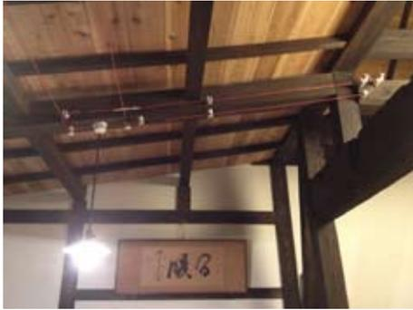
●古民家に合わせて照明器具もレトロ系で統一。ネットオークションでノブ碍子と磁器製ローゼットを競り落とし、碍子引き配線とした。これは増築部分の天井に電線を通せるスペースがなかったこともある。電球はの4WのLED球を採用。写真の色とはかなり異なり、柔らかな電球色で裸電球の風情を十分に再現できた。
