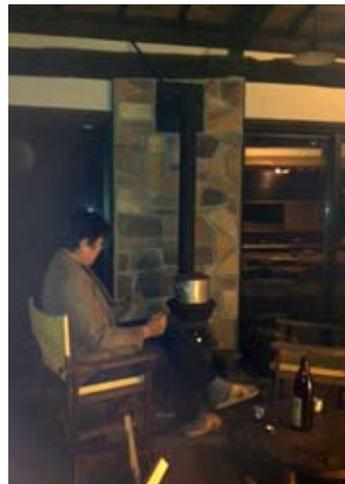
●ネットで注文したダルマストーブを設置。薪をくべながらゆっくり眺めるのが楽しみに。性能を心配していたが、まったく問題なくよく燃える。ストーブ周りには熱を遮断するため、漆喰の中に石を埋め込んでみた。煙突は壁に開けた角穴にメガネ石を入れて遮熱してある。
