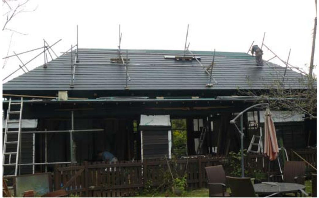
●屋根工事が進行。ルーラーフィングシートの上に鉄板が貼り上げられていく。
