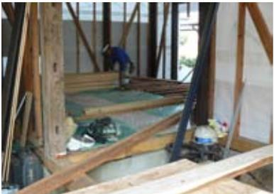
●壁の断熱にはグラスウールを使用。柱が露出する真壁なので、この段階で配線工事を行っておく。後から通すことはできないのだ。
