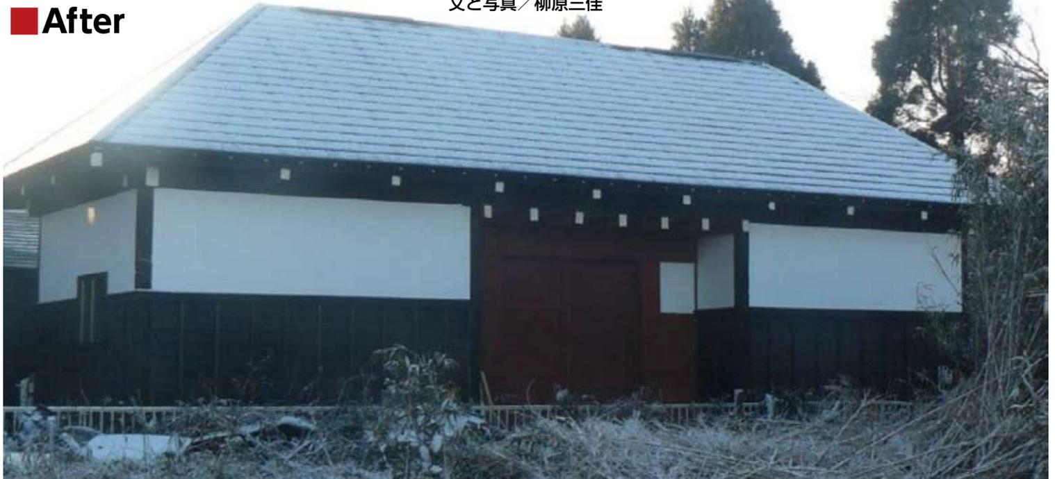
●移築を終えた長屋門。瓦屋根だったものをガルバリウム鋼板葺きとしたのは、地震対策で上部構造を軽くするのと予算低減というふたつの目的がある。写真は2012年2月、千葉県にこの冬初の積雪があったときのもの。
